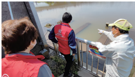
5/8 二郷半領中川揚水機場 管理業務現場確認
